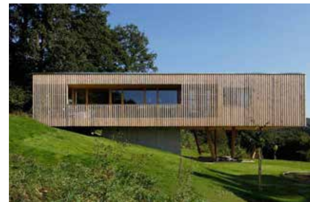
Privacymanagement woningen op de haha's; boven is het privaat, beneden is het publiek.
