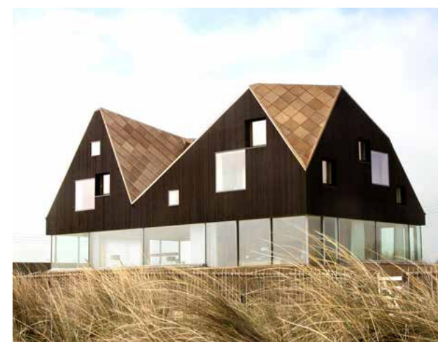
Glazen gevels op de begane grond geven transparantie en laten zien wat er binnen gebeurt.
